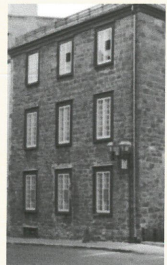
die ersten Räume in der Fliedergasse
